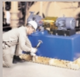
Install bottom edge forms
