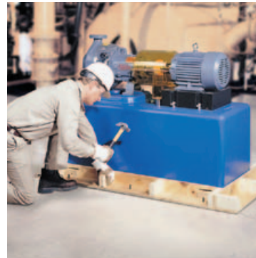
Install bottom edge forms.
