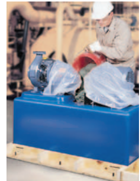
Pour regular 200 bar (3000 psi) concrete.
